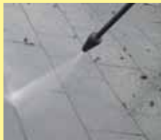
屋根高圧洗浄
